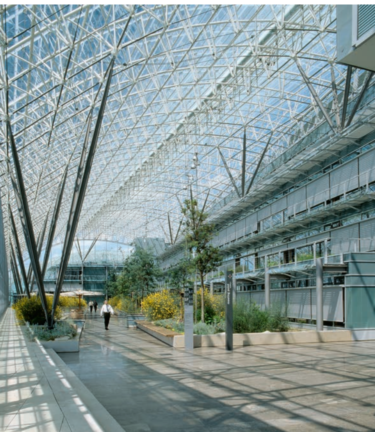
装有关节轴承的屋顶玻璃
